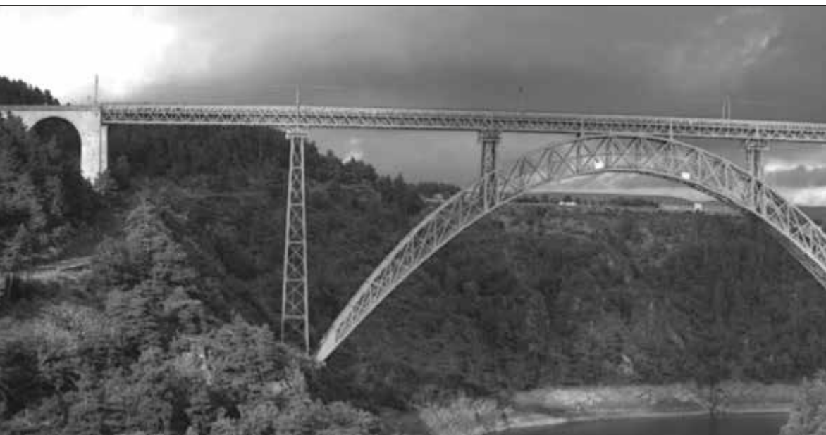
Le viaduc de Garabit, en acier et fer forgé
